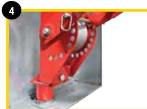
Place in conduit
